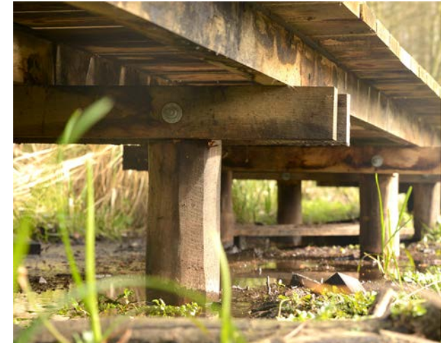
Konstruktionsprincip af træsti i Vejerslev Skov.
