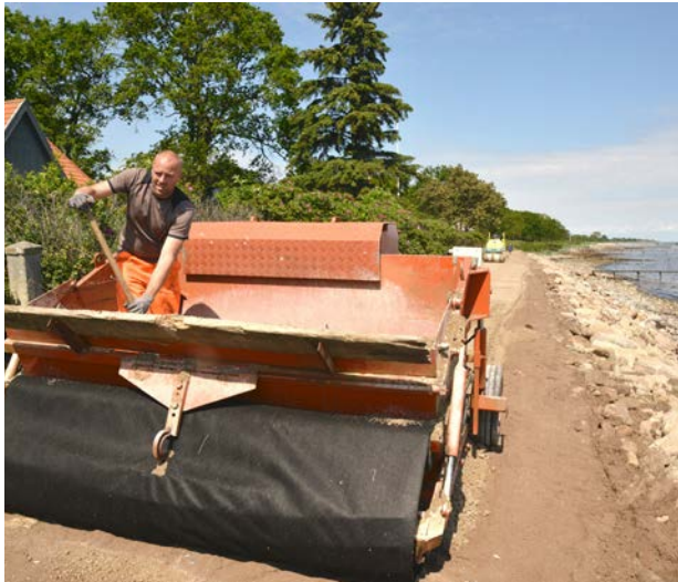
Ny kørefast belægning i cykelgrus udlægges i aftalt bredde på en måtte af geotekstil, Kyststien ved Hov
