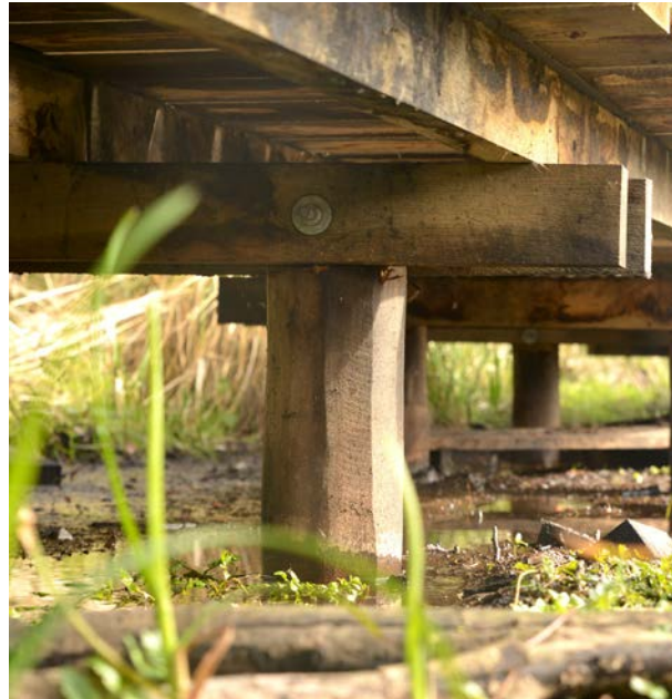
Konstruktionsprincip af træsti i Vejerslev Skov.
