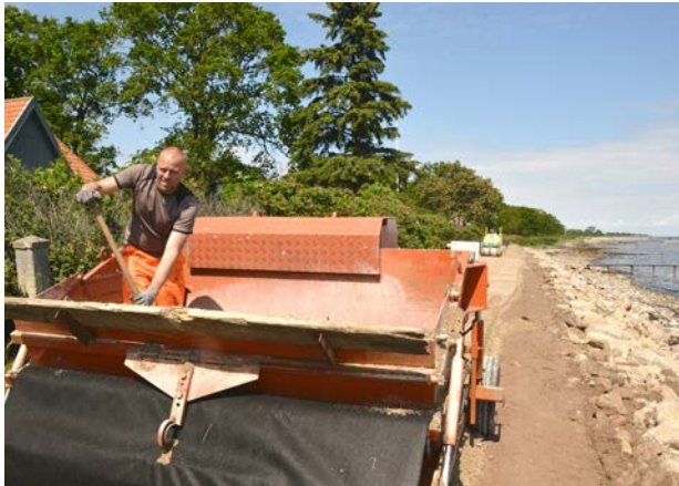
Ny kørefast belægning i cykelgrus udlægges i aftalt bredde på en måtte af geotekstil, Kyststien ved Hov
