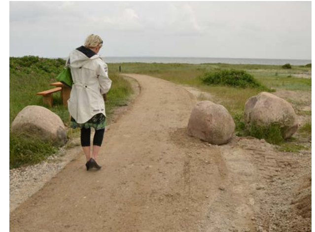
Nyudlagt belægning i cykelgrus, Kyststien ved Hov
