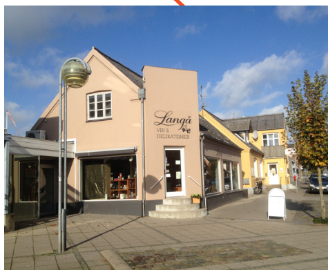
Nyere renoveret vinforretning beliggende midt i Bredgade.
